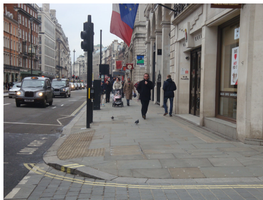
3. Piccadilly, Londra 2013. Il LOGES segnala il nodo tra marciapiede e attraversamento pedonale ma non "guida" fino al muro che potrebbe rappresentare la guida naturale della persona non vedente.
