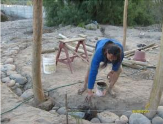
Ilustración 7: Taller de construcción
