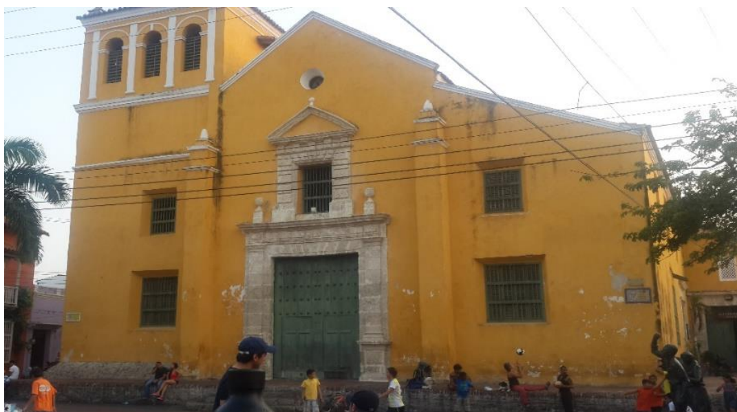
Ilustración 12 Iglesia de la Santísima trinidad, fuente: Elaboración propia (2016)
