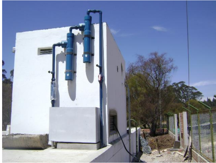
Figura 21. Planta de tratamiento de Agua Residual La Fuente.
