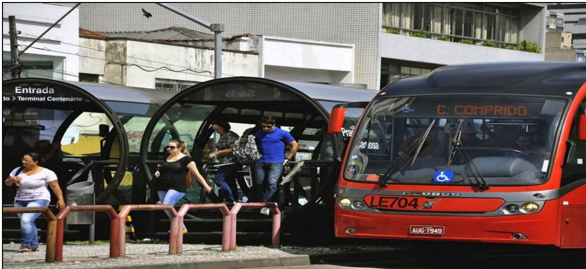
Figura 9. Infraestructura de sistema BRT en Curitiba
