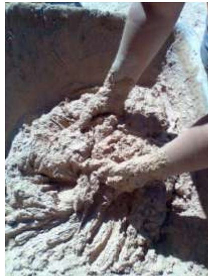
Mezcla de adobe (Arcilla de lugar agua y paja)
