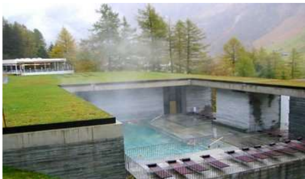
Imagen 15 Exterior Muro en Piedra
