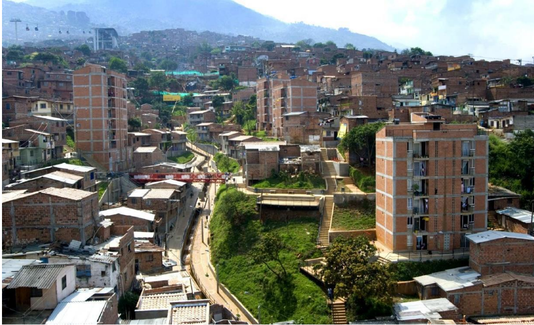
Figura 14. Proyecto finalizado quebrada Juan el bobo. Plan de mejoramiento integral de barrios (2012)
