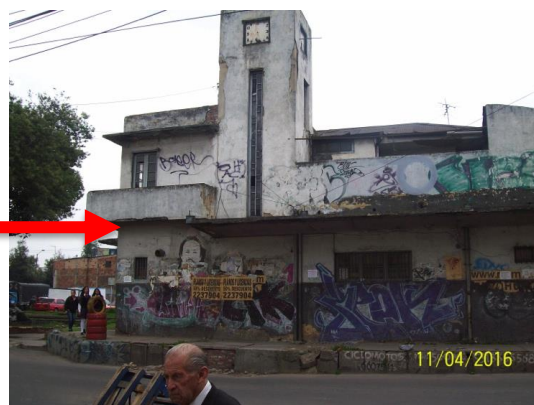
Foto2. Evidencia de la problemática, Fotografía del Autor, 2016
