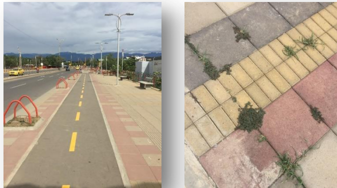
Fotografía 6. Zonas en buen estado // Falta de mantenimiento a los árboles plantados y limpieza
