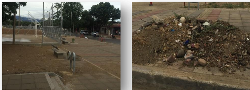
Fotografía 7. Zonas sin limpieza // Daños en el mobiliario y zonas verdes secas
