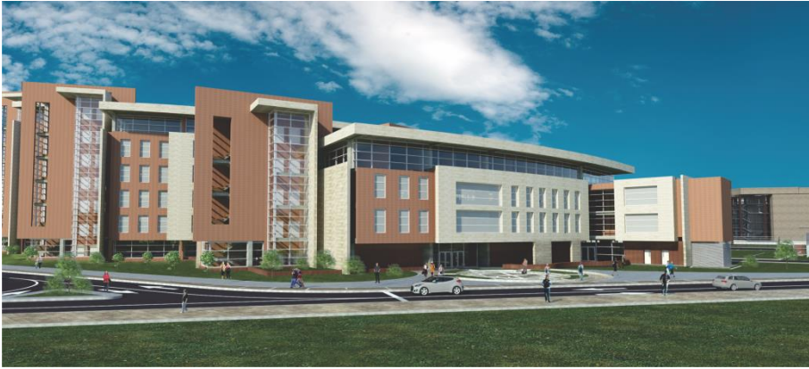
Imagen 47: Fachadas Edificio de Aulas
