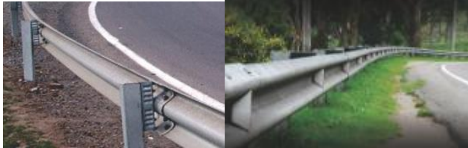
Figura 5. Defensas metálicas viales. Fuente: (Peralta Perfileria SAS, 2015).
