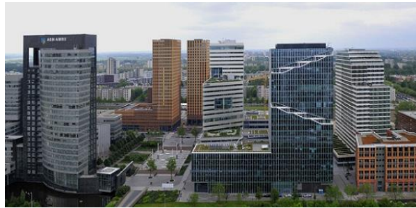
Imagen 11. Torres de oficinas y vivienda en el distrito de Zuidas Fuente: http://www.absolutholanda.com/famosos-barrios-de-amsterdam-zuidas/
