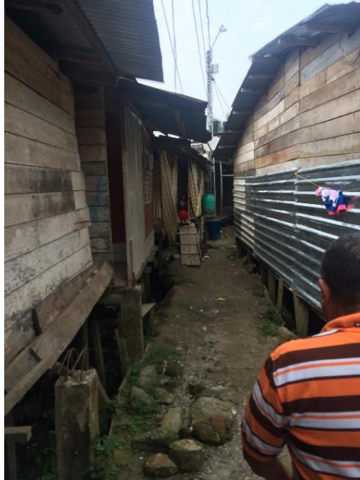
Figura 19 Vivienda en madera y zinc. Fuente: Foto Lilian Heredia/ Marzo 2016
