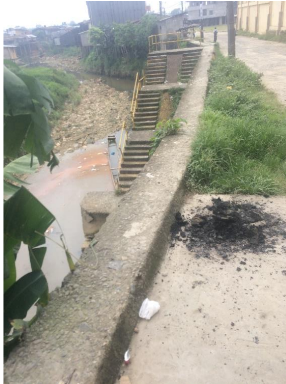
Figura 12. Muro de contención Fuente: Foto Lilian Heredia/ Marzo 2016
