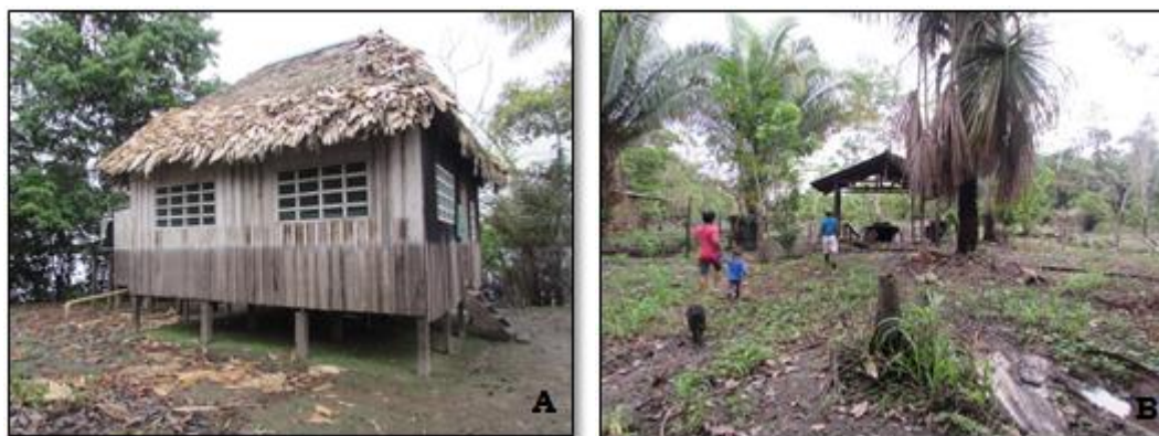
A. Elevación de estructuras para el periodo de inundación. B. Muestra de una chagra El autor, 2015
