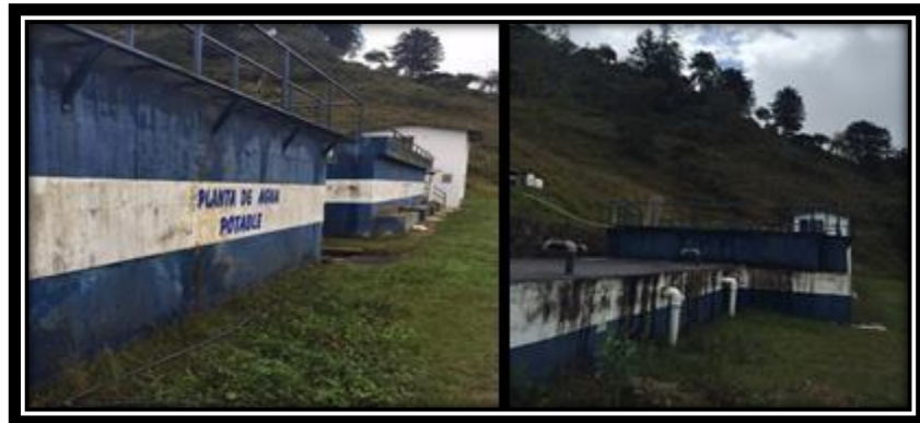
Figura 21. PTAP de Mortíñal
