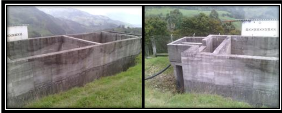
Figura 20. Desarenador en construcción
