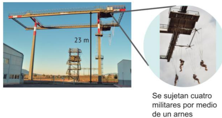
Grafica 16 Torre de descenso Fuente: Escuela militar de paracaidismo Méndez Parada (Aire, 2013)
