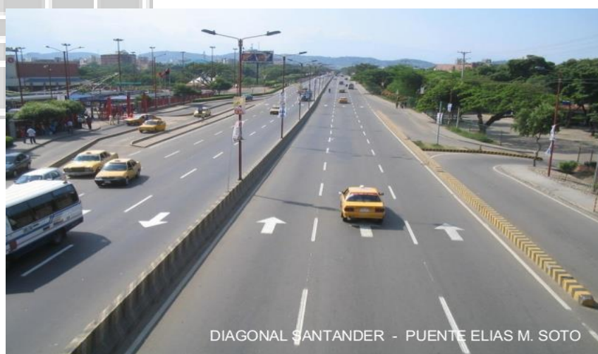
Figura 10. Diagonal Santander Puente Elías M. Soto. Fuente: Google
