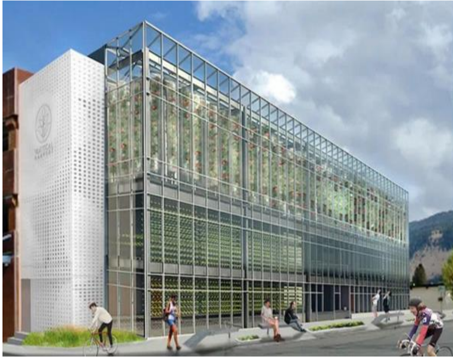
Figura 19. Por fuera de la Granja vertical. Fuente: (Ecoinventos, green Technology)
