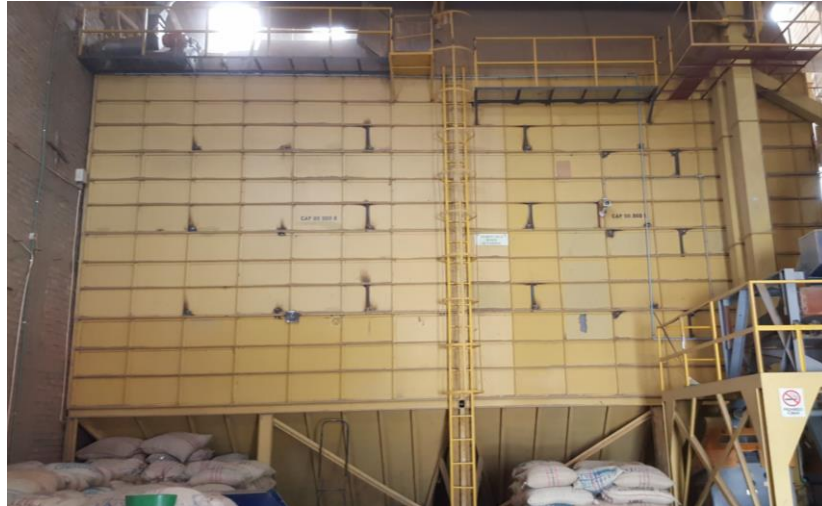
Figura 7. Silos de almacenamiento de café pergamino
