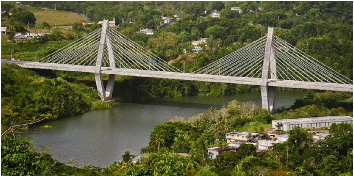
Fuente: Puente atirantado de Naranjito, Jesús Izcoa Moure (Puerto Rico)
