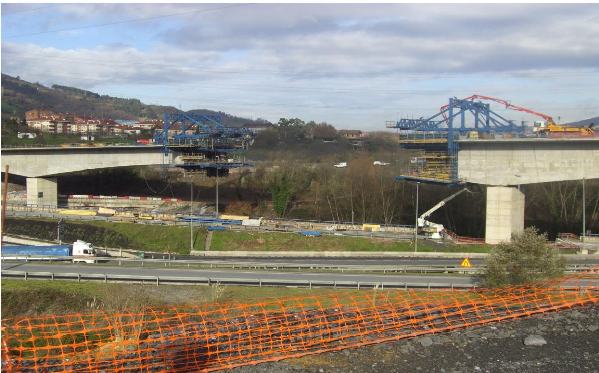
Ilustración 51 Construcción puente proceso constructivo voladizos sucesivos
