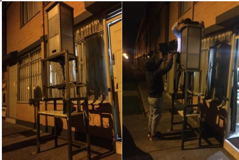
Figura 82. Ensamblaje de la estructura.
