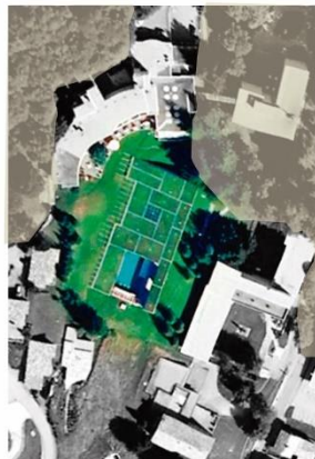
Figura 51: Conexión con la Naturaleza, Termas de Vals. Septiembre de 2016 Imagen en Línea (Editada por el Autor) Fuente: http://www.plataformaarquitectura.cl/ - 2015
