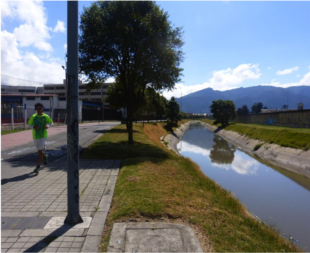
Figura 15. Estado actual del canal del Salitre a la altura de la calle 68. Fuente: Propia
