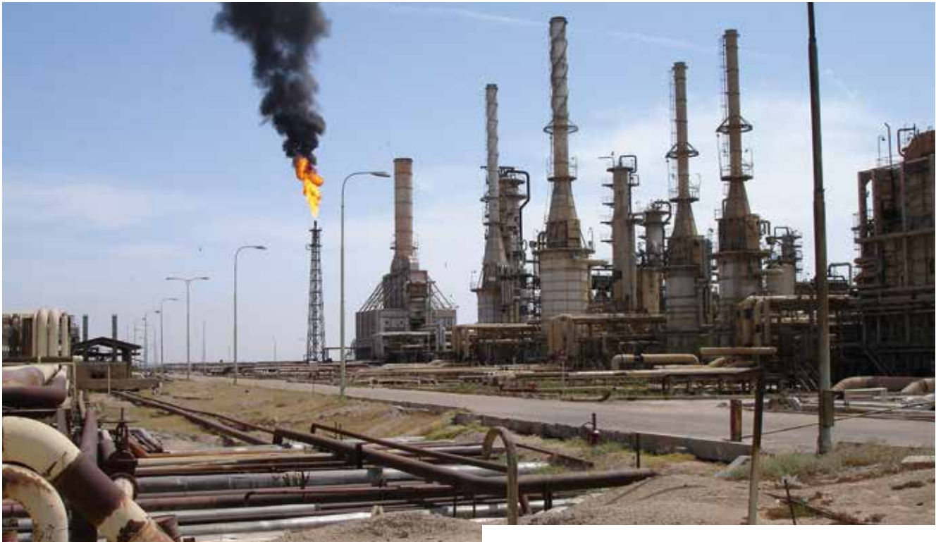
Verarbeitungsanlage für Rohöl im Irak. Bild: Fotolia © superkiss
