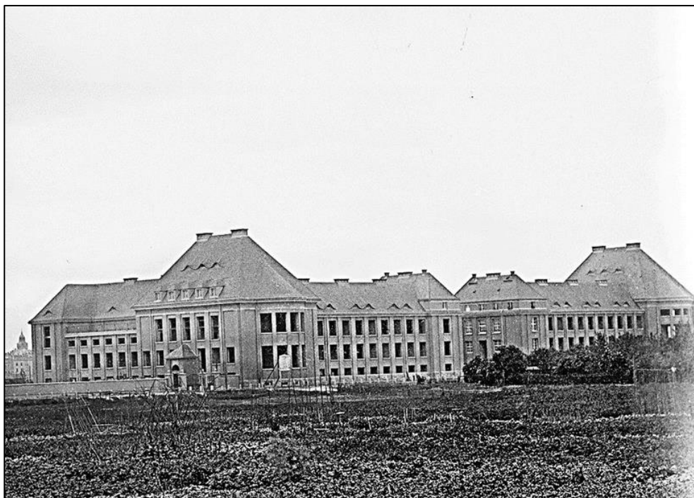
Abbildung 1: Rohbau der Ostseite der Fakultät mit der Pathologie und der Anatomie.
