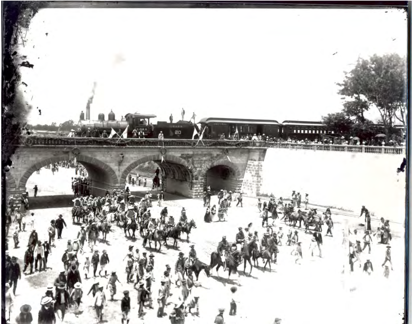
FIGURE 9 Viaduct of the Baranquilla. Source: Archivo Histórico-Fotográfico de la Academia de Geografía é Historia de Guatemala. Colección de Alberto G. Valdeavellano, CG.
