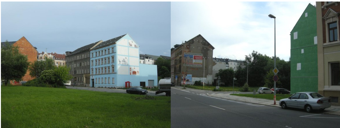
Abb. 34: Perforierte Karreestruktur im Bereich des mittleren Sonnenbergs
