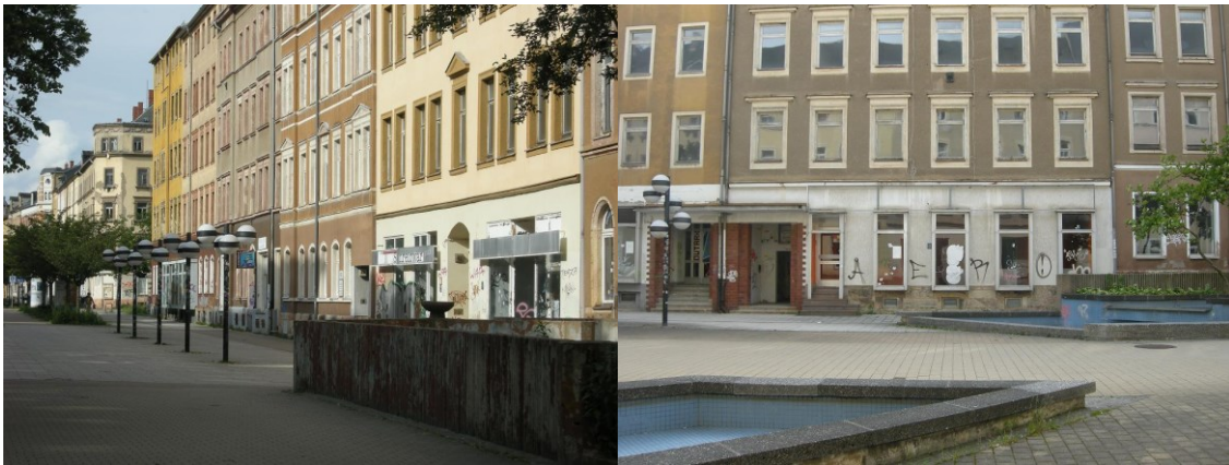
Abb. 29: Leerstand und Spuren von Vandalismus auf dem Brühl-Boulevard
