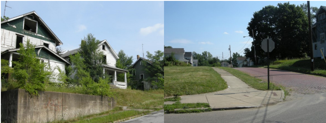
Abb. 42: Verfall leerstehender Wohngebäude und Verlust des ursprünglichen Raumgefüges nach Abrissen
