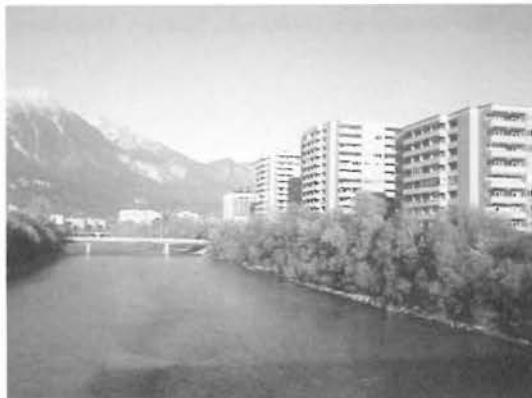
Abbildung 1: Die UMIT befindet sich zur Fertigstellung ihres eigenen Gebäudes im Ausbildungszentrum West der TILAK, Innrain 98, Innsbruck (3. Gebäude von rechts).
