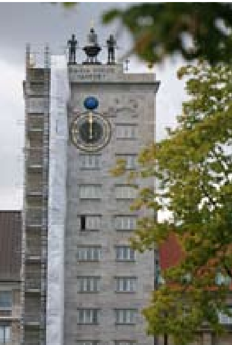
Sanierung des Krochhauses
