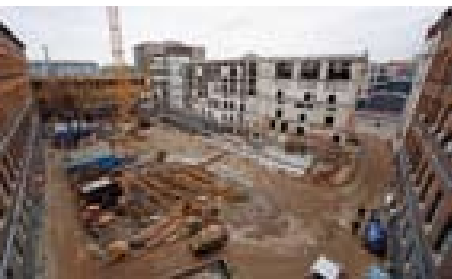
Umbau der Universitätshautklinik
