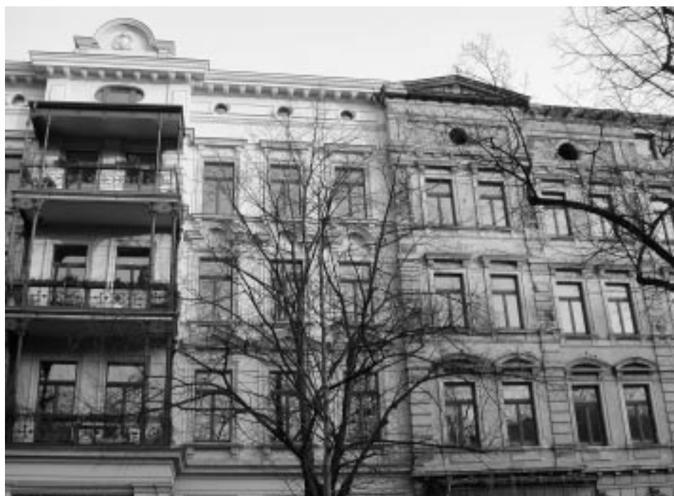
In Leipzig ein alltägliches Bild: ein saniertes Gründerzeithaus neben einem unsanierten, hier in der August-Bebel-Straße.
