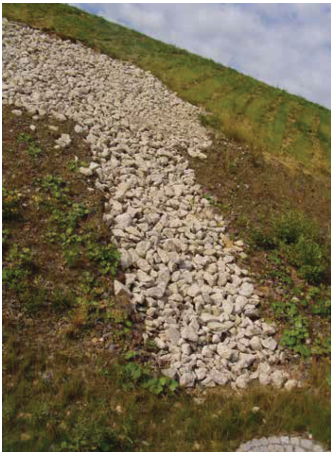
Abb. 3: Sanierung von Rutschungen
