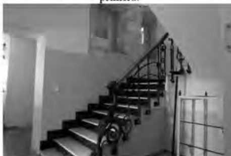
2.6. Escalera de acceso a plantas altas.
