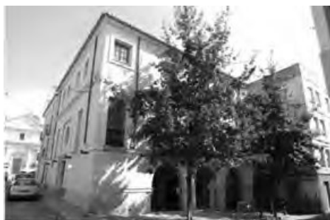
2.1. Fachada principal del edificio. Acceso cuando estaba destinado a ayuntamiento.
