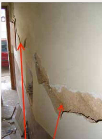
ESQUERDA (2), DE TRAÇA SENSIBLEMENT HORIZONTAL, QUE PENETRA OBLIQUAMENT EN L'INTERIOR DE LA SECCIÓ
