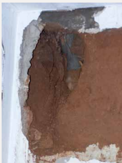
FIG. 6: IMATGES DE LESIÓ DE LIQÜEFACCIÓ EN PARET DE FAÇANA DE TÀPIA
