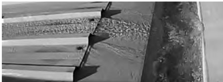
Figura 9: Turbulencia sobre el canalón por la entrada lateral de agua.
