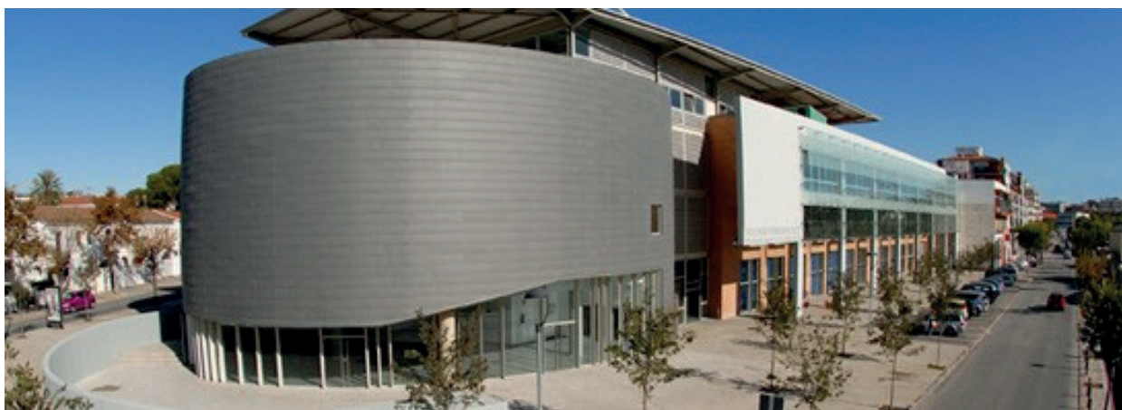
Figura 1. Imatge de l'edifici Neàpolis, a Vilanova i la Geltrú
