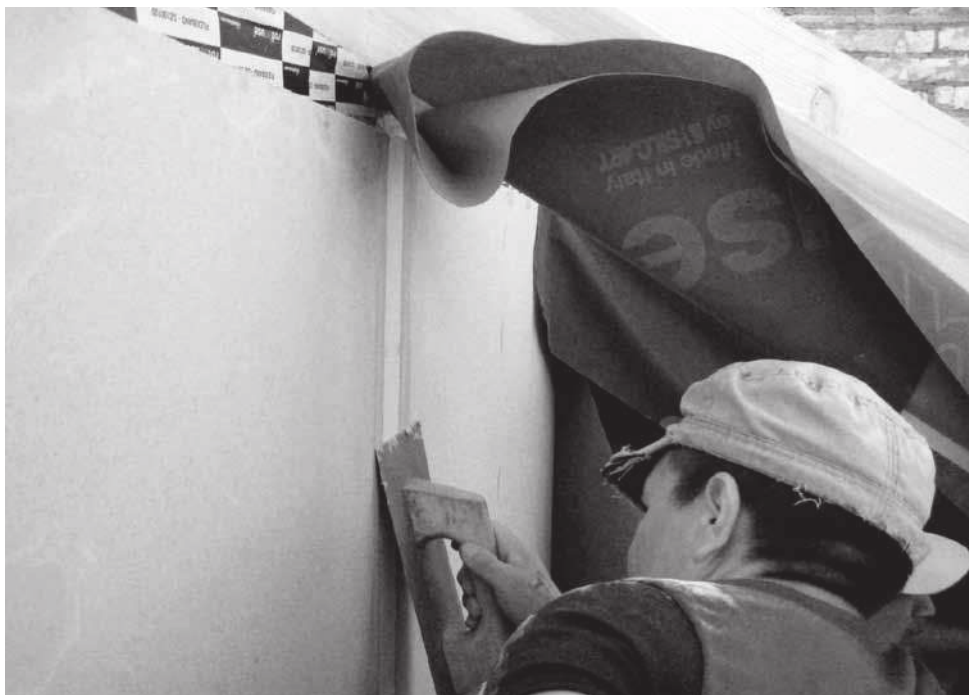
Figura 8. Detalle sellado entre diferentes materiales. Autor: Marc Folch
