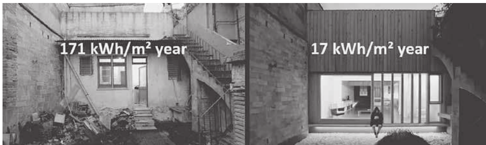
Figura 13. Estado actual y rehabilitación energética. Fachada noroeste. Autor: Marc Folch
