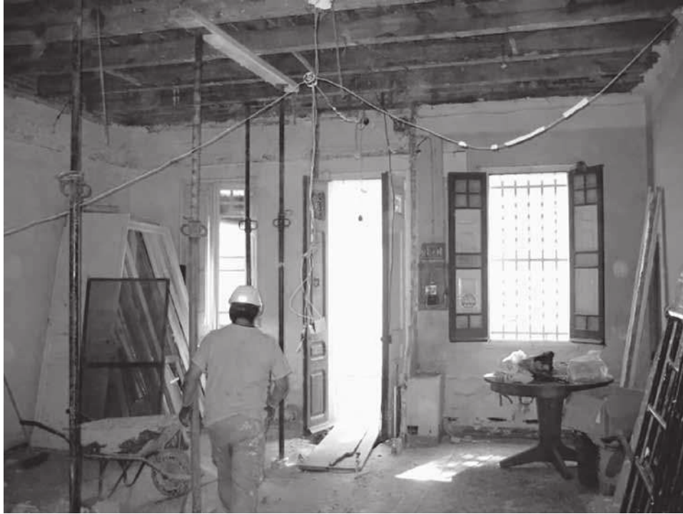
Figura 2. Estado actual. Interior vivienda. Autor: Marc Folch
