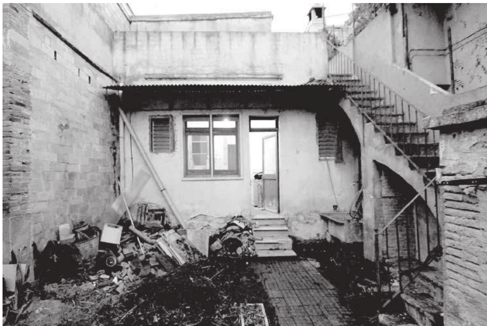
Figura 1. Estado actual. Fachada noroeste. Autor: Marc Folch
