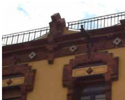
A L'ANTIGA FÀBRICA DEL GAS, LES GRALLES CRIAVEN EN FORATS DE VENTILACIÓ QUE ES VOLIEN TAPAR PER EVITAR QUE S'HI CONTINUÉSSIN INSTAL·LANT ELS COLOMS. LA SOLUCIÓ HA ESTAT REDUIR-NE EL DIÀMETRE (FOTO DE LA DRETA)
