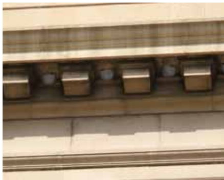
REHABILITACIÓ DE LA FAÇANA DE L'EDIFICI DE CORREUS A BARCELONA, AMB NIUS D'ORENETA CUABLANCA
