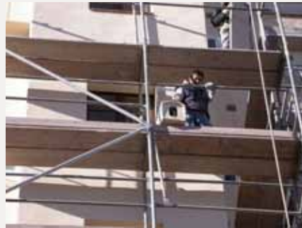
COL·LOCACIÓ DEL NIU ARTIFICIAL
