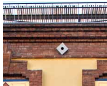
A L'ANTIGA FÀBRICA DEL GAS, LES GRALLES CRIAVEN EN FORATS DE VENTILACIÓ QUE ES VOLIEN TAPAR PER EVITAR QUE S'HI CONTINUÉSSIN INSTAL·LANT ELS COLOMS. LA SOLUCIÓ HA ESTAT REDUIR-NE EL DIÀMETRE (FOTO DE LA DRETA)
