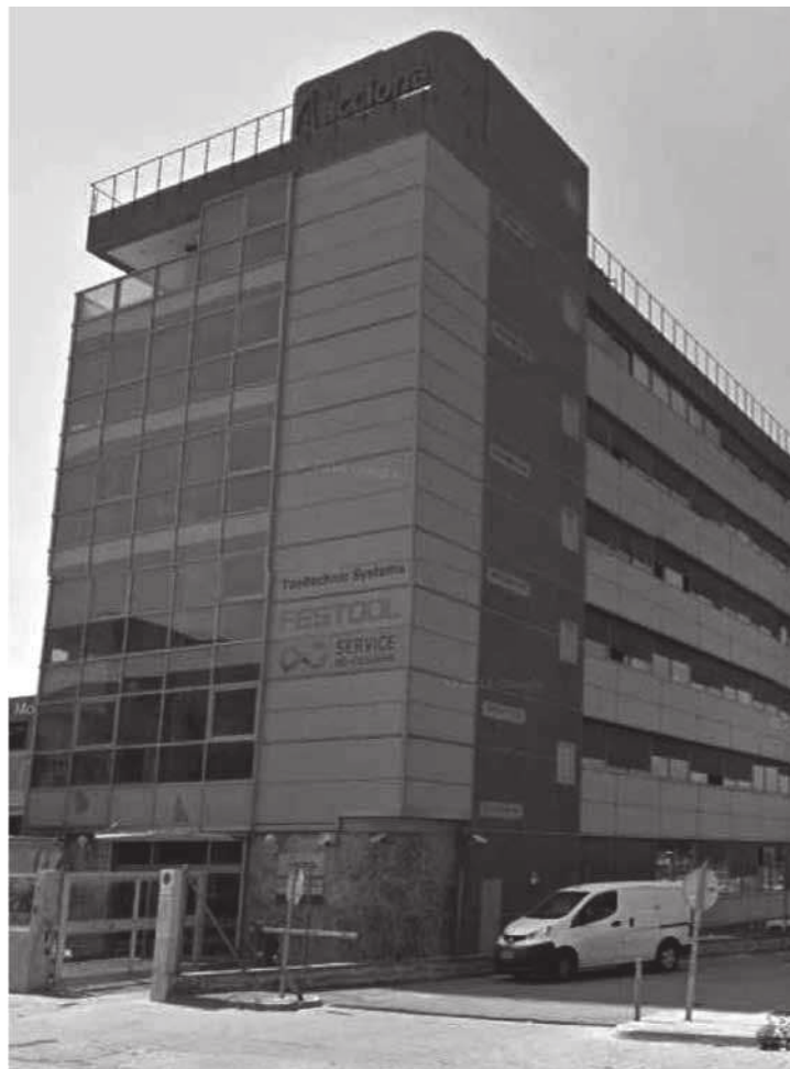
Figura 1. Vista general del edificio. Fuente: Acciona Ingeniería S.A.
