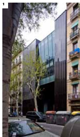
1. IMATGE DE LA FAÇANA EXTERIOR AL CARRER COMTE BORRELL. FAÇANA RESOLTA AMB PANELLS DE XAPA MICROPERFORADA DE COLOR ALBERGÍNIA (I NO NEGRE, COM POT SEMBLAR).
