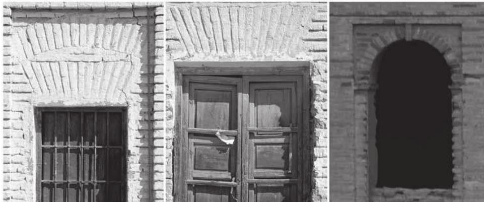
Figura 8. Soluciones empleadas en los huecos de fachada.
