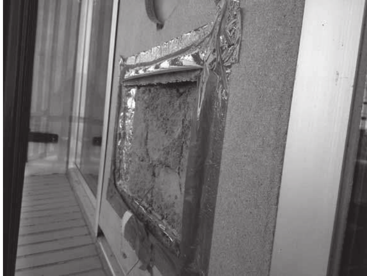
Figura 3. Vista de la cara exterior (tierra proyectada) del sistema constructivo termoarcilla-tierra proyectada y del sensor situado en la superficie de la tierra (termopar T-2) (Fuente: autores).
