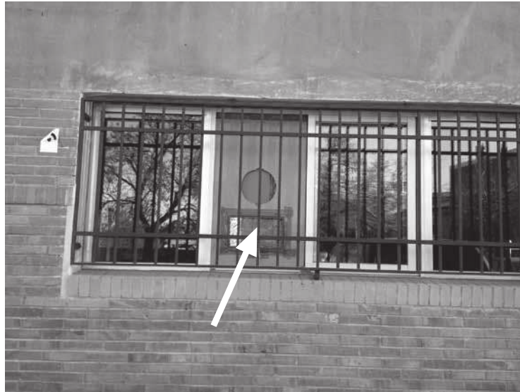
Figura 2. Ubicación del dispositivo de ensayo en la fachada SSE de la E.T.S. Ingeniería de Edificación de la Universidad de Granada en el que se aprecia la disposición del prototipo en su cara externa, es decir, la de la tierra proyectada (Fuente: autores).
