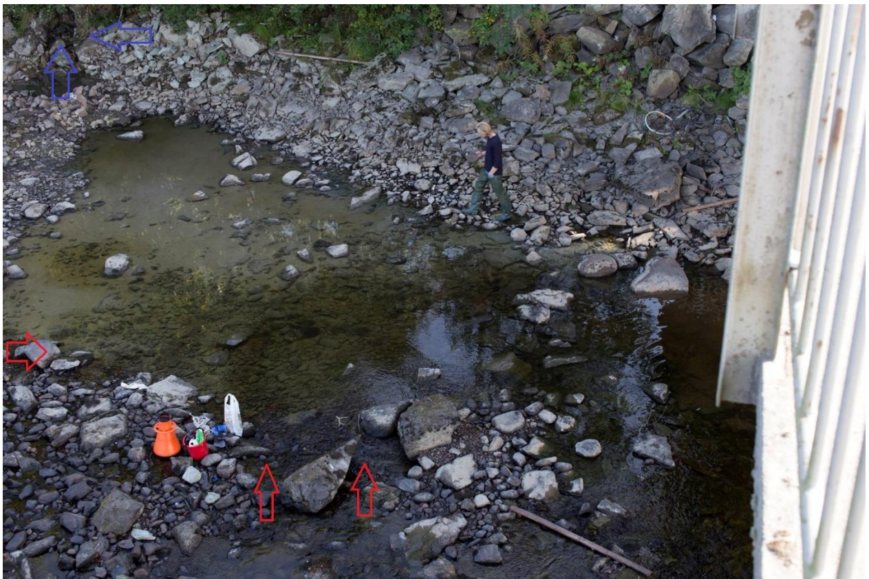
Figur 3: Bilde tatt fra Håkkadalsbrua. Blå piler illustrerer utslippsstedet, og røde piler illustrerer tilstrømmingen av friskt vann. Foto: Terje Nilssen
