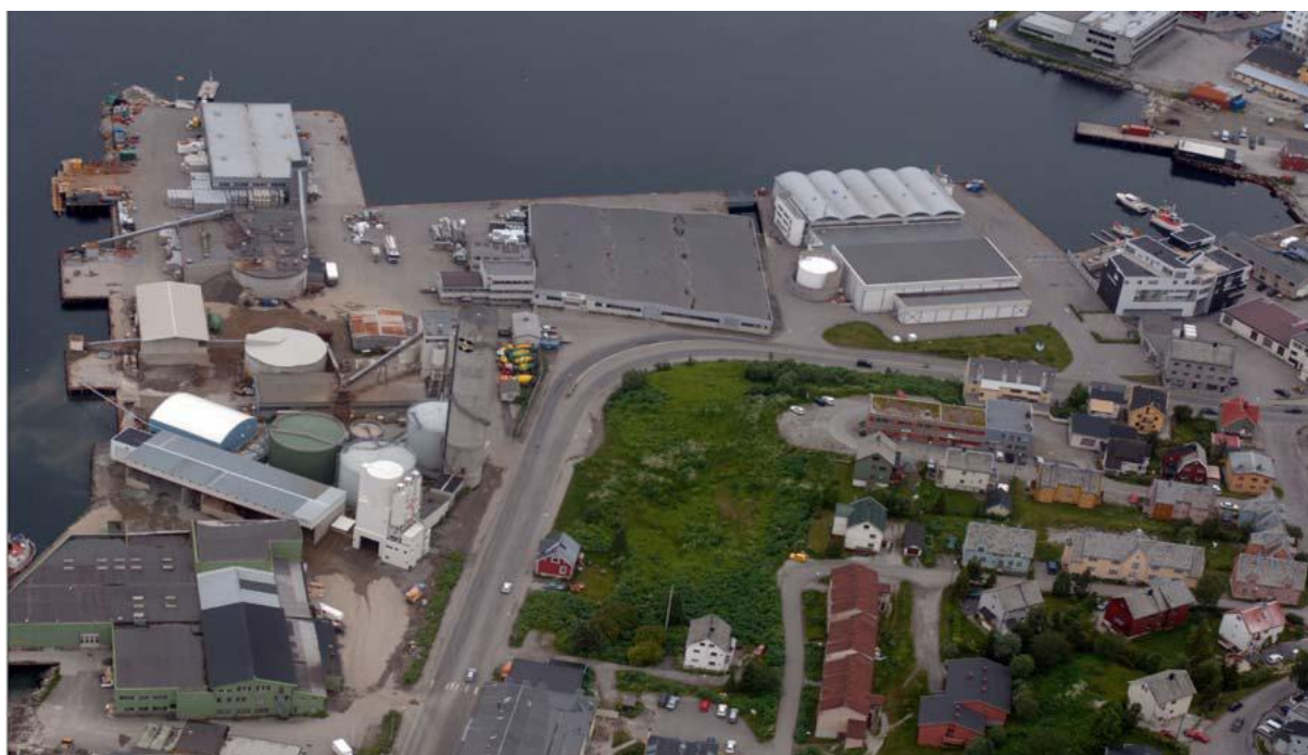
Bilde 1: Planlegging og bygging av ny brannstasjon i Tromsø kommune.
