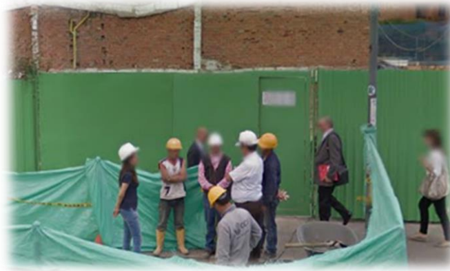
Fotografía 4. Inmueble en construcción
