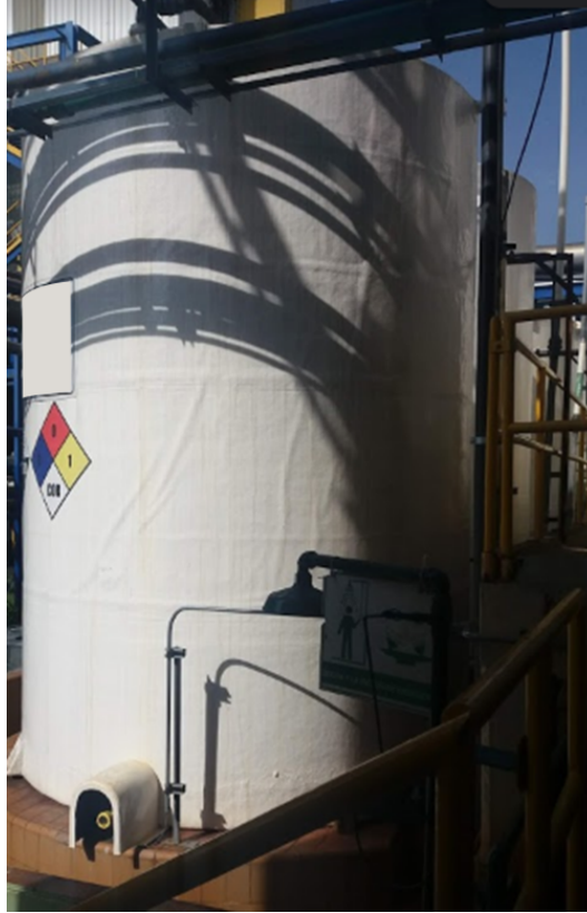
Figura 16: Instalación del sensor en los tanques
