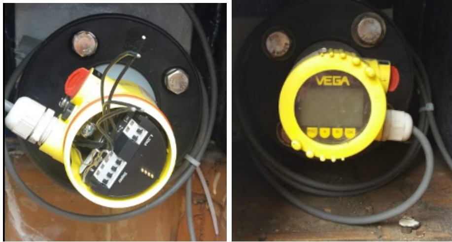
(a) Conexión sensor de presión
