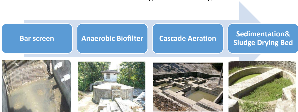
Gambar 7. Kondisi Unit Pengolahan IPAL Mergosono
