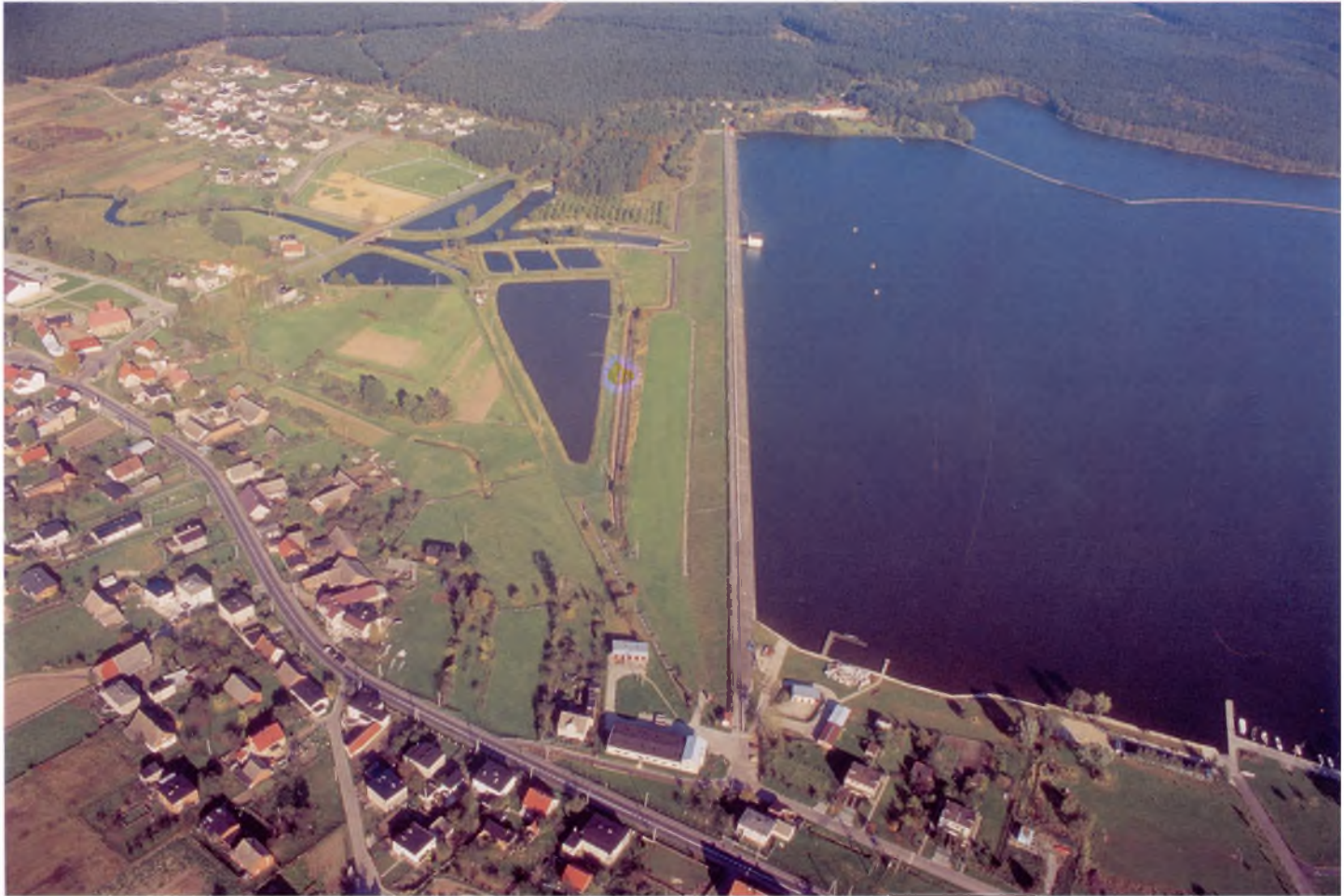
Fot. 6. Zapora czołowa zbiornika rybnickiego w Stodołach (fot. A. Kuczera) Phot. 6. Frontal dam of Rybnik Reservoir in Stodoły (Phot. A. Kuczera)
