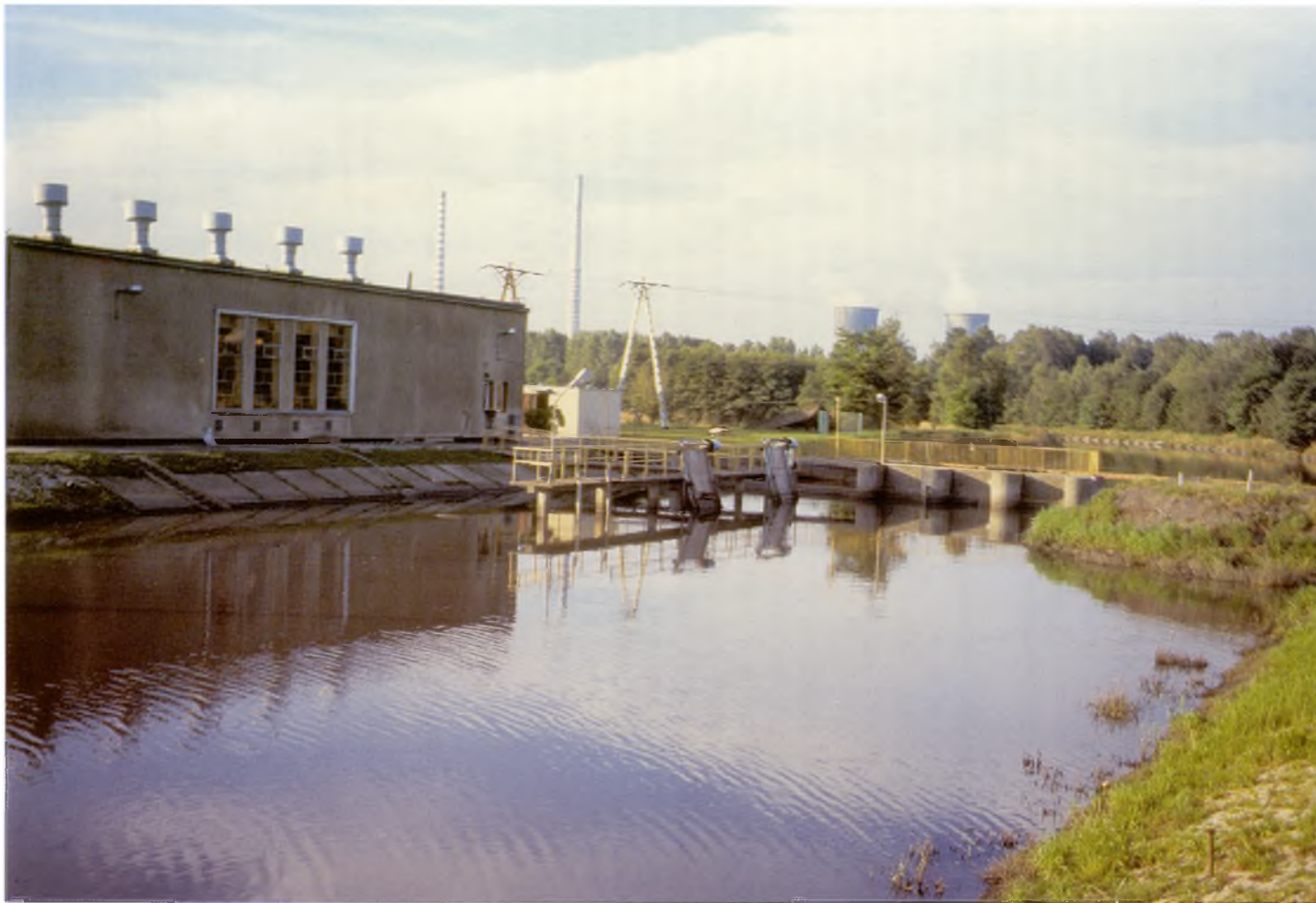
Fot. 5. Jaz i przepompownia w korycie Nacyna przetrzucająca jej wody poniżej zapory Jeziora Rybnickiego Phot. 5. Dam and pumping-station in Nacyna channel which transfers the river water below the Rybnik Reservoir dam
