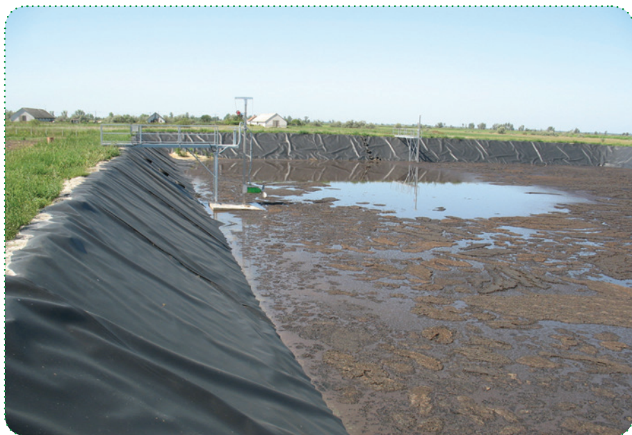
9. kép: Fóliaborítású, nem fedett, hígrágyatároló, beépített homogenizáló berendezéssel
