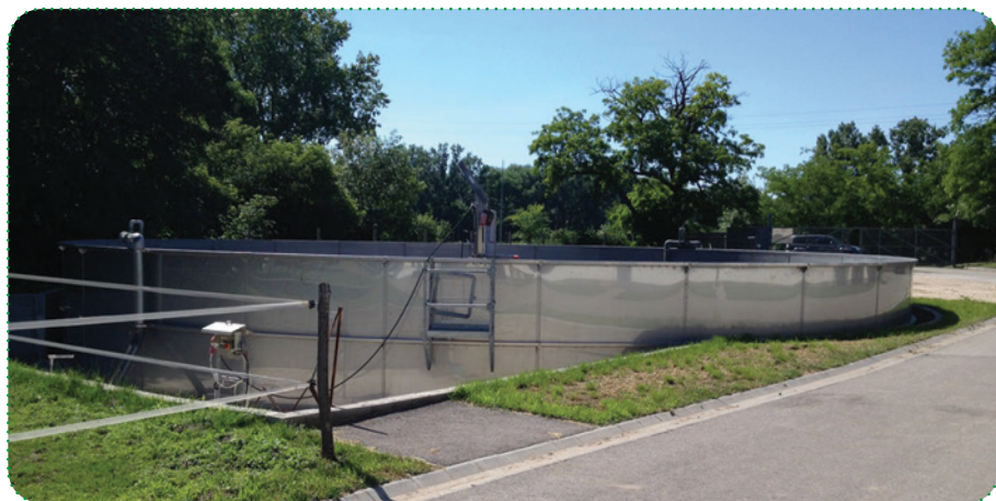
5. kép: Fedés nélküli, szivárgásmentes acél hígtrágyatároló
