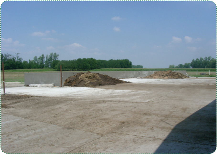
8. kép: Oldalfallal lezárt istállótrágya-tároló
