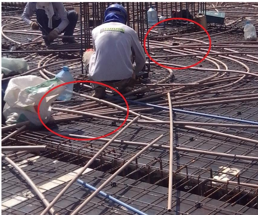
Figura 8 – Disposição dos eletrodutos durante execução da obra analisada
