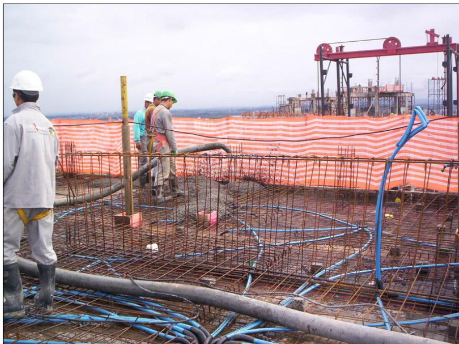
Figura 6 – Disposição de eletrodutos em laje maciça de concreto armado
