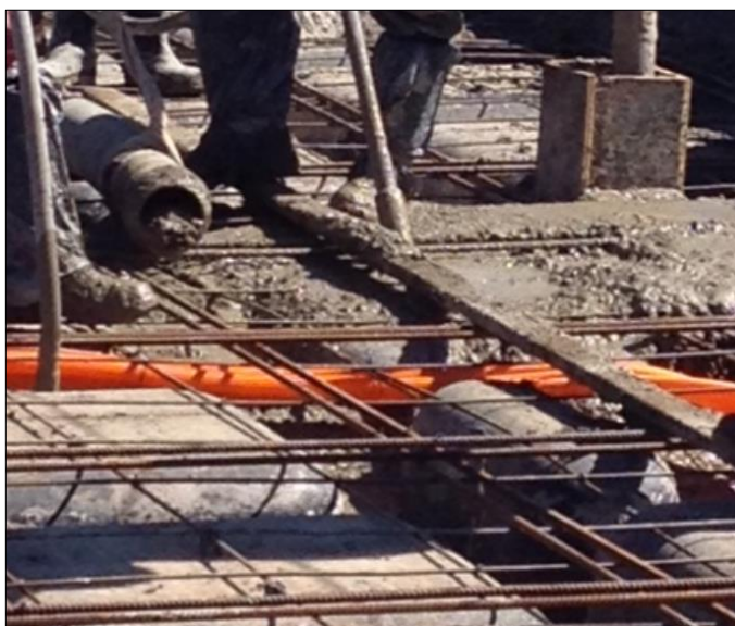
Figura 1 – Execução de elemento estrutural em concreto armado
