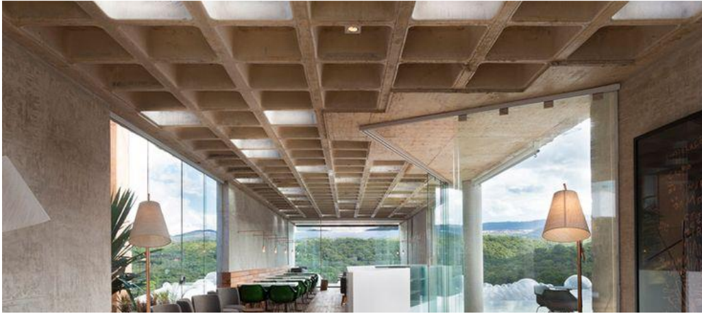
Figura 2: Construção residencial de laje nervurada com aberturas na mesa.
