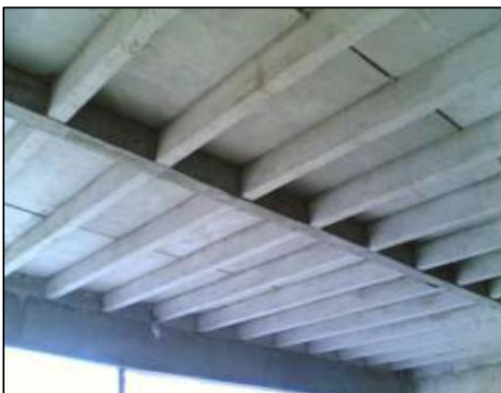
Figura 7: Exemplo de laje unidirecional
